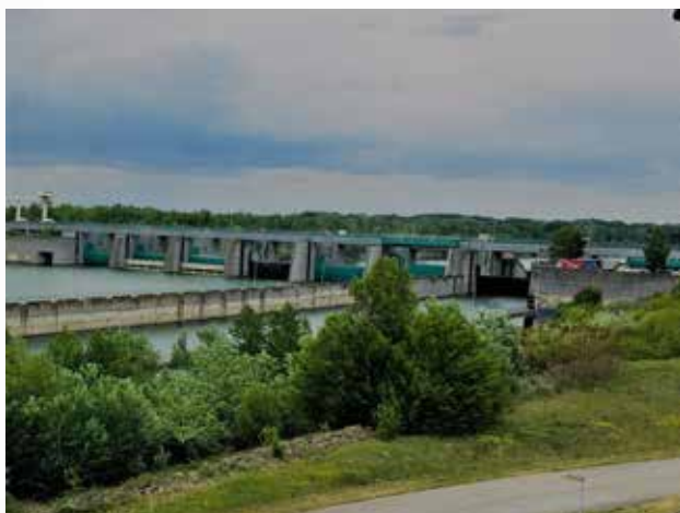
Nagy műtárgyak felújítása
